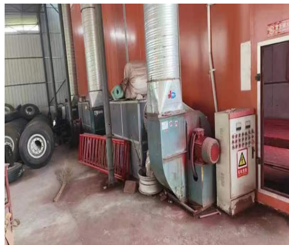
水帘+纤维过滤棉+活性炭+3 根（1#和 3#排气筒高 15m，2#排气筒高 16m）排气筒
